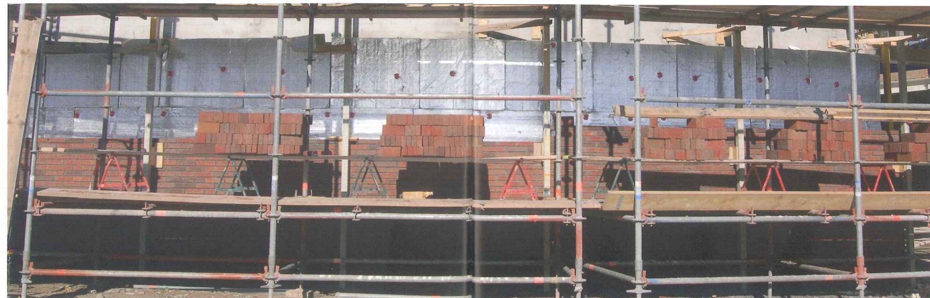
Dagelijkse praktijk van het aanbrengen van spouwankers: juiste aantallen, posities en patronen worden
