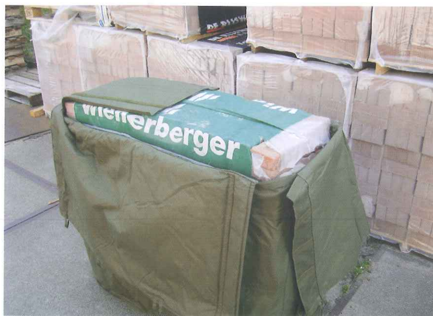
Door stenen binnen op te slaan of in verwarmde bigbags zoals hier, wordt voorkomen dat deze te koud worden.
