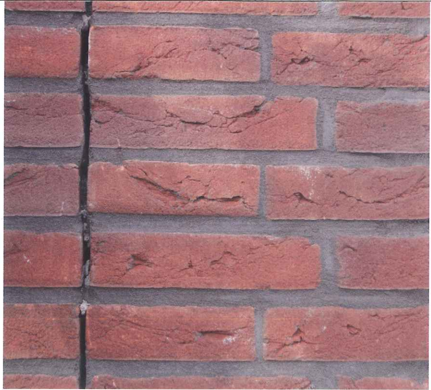
Dilatatievoegen dienen volledig vrij te zijn van specie.
