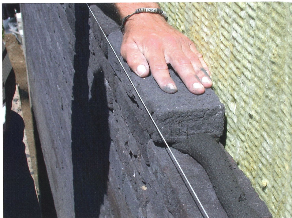
Het lijmen van metselwerk is sinds de jaren negentig een alternatief voor traditioneel metselen.
