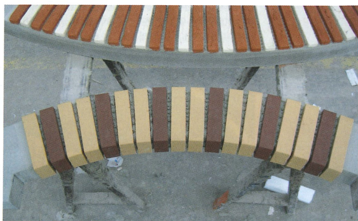
Lateien met volle bakstenen kunnen op veel verschillende manieren worden geproduceerd. Deze zijn geprefabriceerd en op de bouw afgewerkt en gevoegd.
