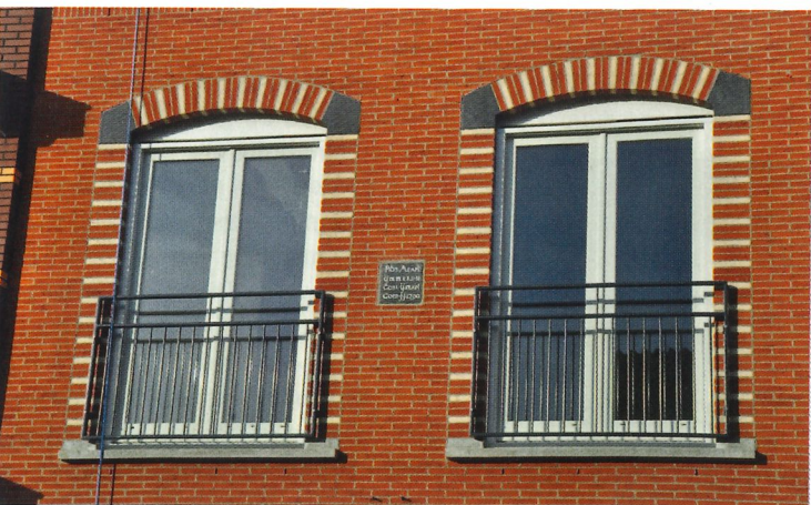
Lateien met volle bakstenen kunnen op veel verschillende manieren worden geproduceerd. Deze zijn geprefabriceerd en op de bouw afgewerkt en gevoegd.
