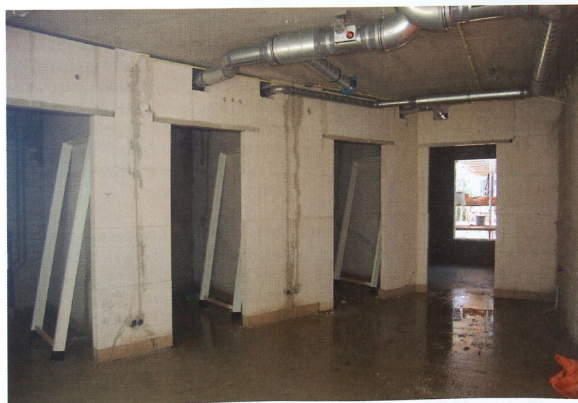
Niet-dragende metselwerk binnenwanden met koud opgelegde betonlateien.
