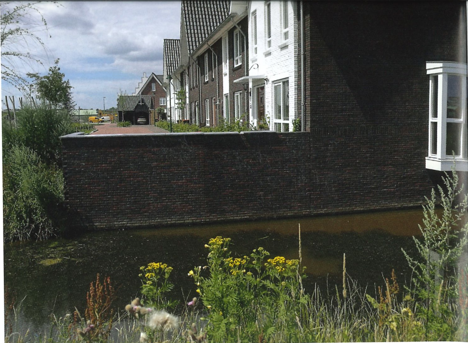
Voor bakstenen metselwerk in water zijn bakstenen met een F2- en vorstklasse D-classificatie nodig.
