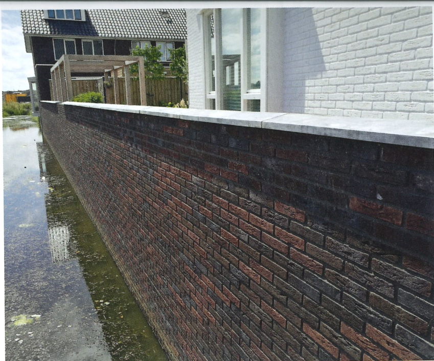
Op basis van de eeuwenlange ervaring met bakstenen metselwerk in waterkerende werken, is er in Nederland in het verleden altijd een zwaardere eis gesteld aan de vorst-dooiweerstand van bakstenen.
