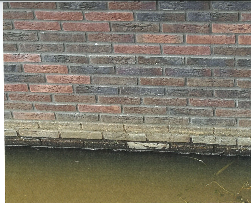
Van belang bij metselwerk onder water zijn de vorstbestandheid van de steen, de wijze van metselen, het voorkomen van schade door optrekkend vocht in het buitenblad en het voorkomen van schade aan het metselwerk door bevriezing van het aanpalende oppervlaktewater.
