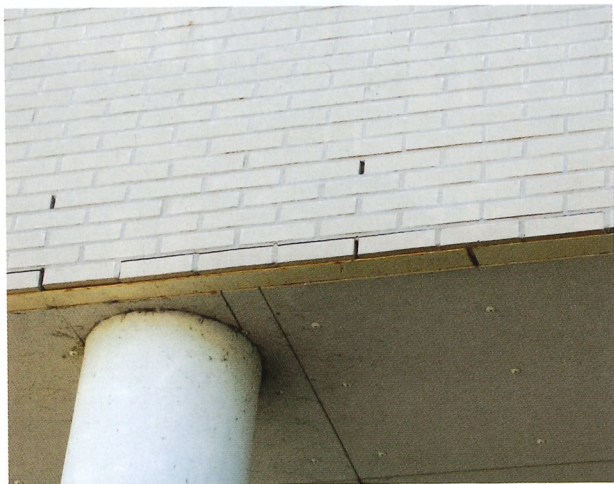
Kortetermijnevol- gen van verkeerde bescherming geveldrager en te grote doorbuiging van de geveldrager.
