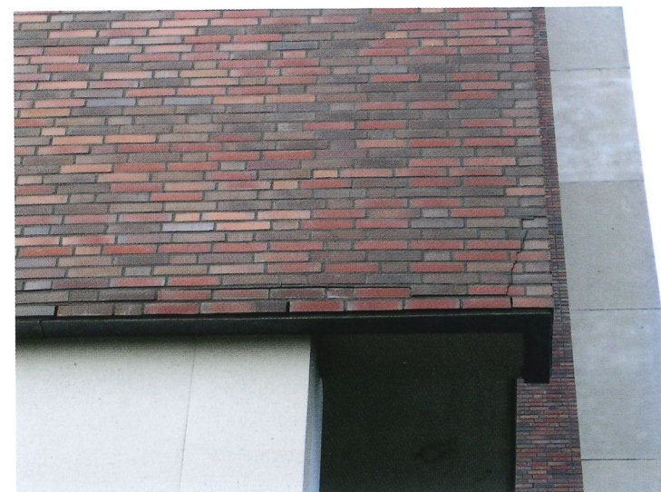
Foto rechtsonder Doordragen van geveldrager op onderliggende metselwerk.
