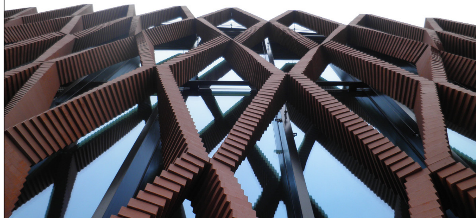
Iedere kolom is uniek in het raster van de gevel van de ovenhal/kantoor Keller Ziegeleien te Pfungen © Harrie Vekemans, Adviesbureau Vekemans
