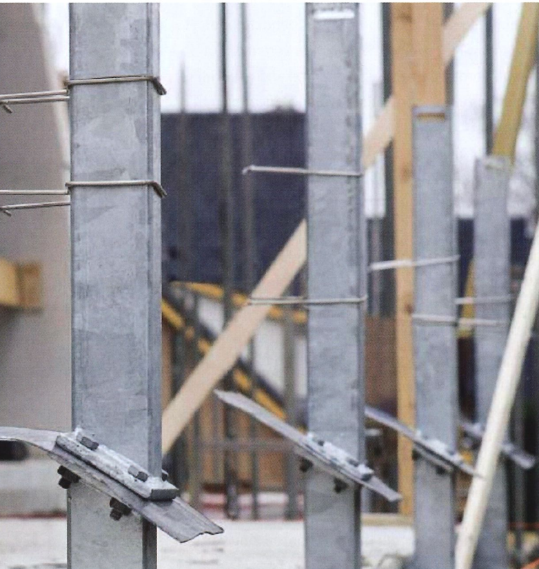
Spouwankers voor borstweringssteunen.
