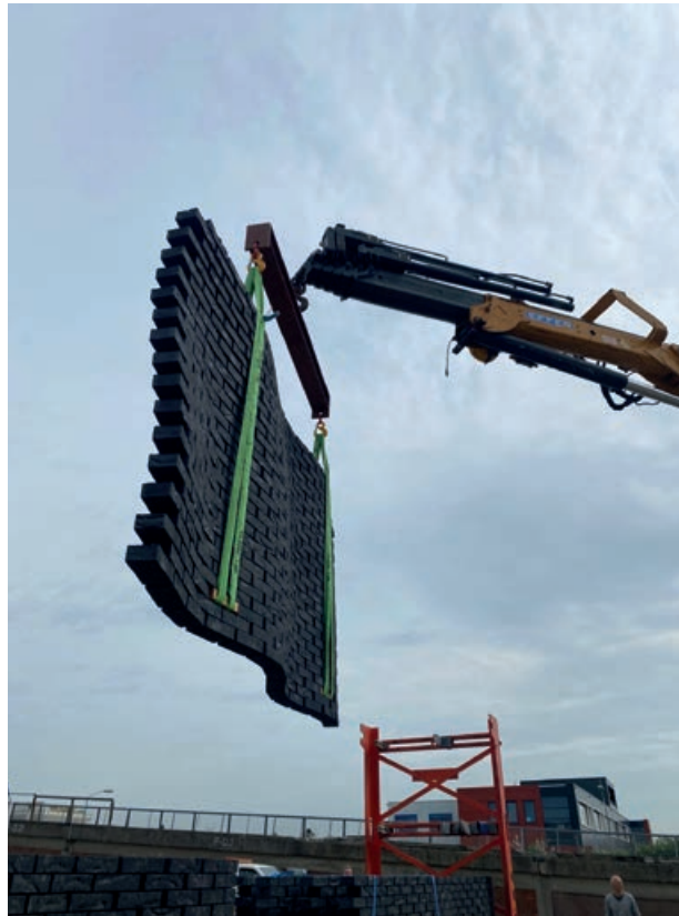
Met de metselrobot van Stack3D is een bakstenen gevel van het nieuwe Living Lab van 3D Makers Zone te Haarlem gerealiseerd. (Foto's: Marcel Ruben en Bouwlab)
