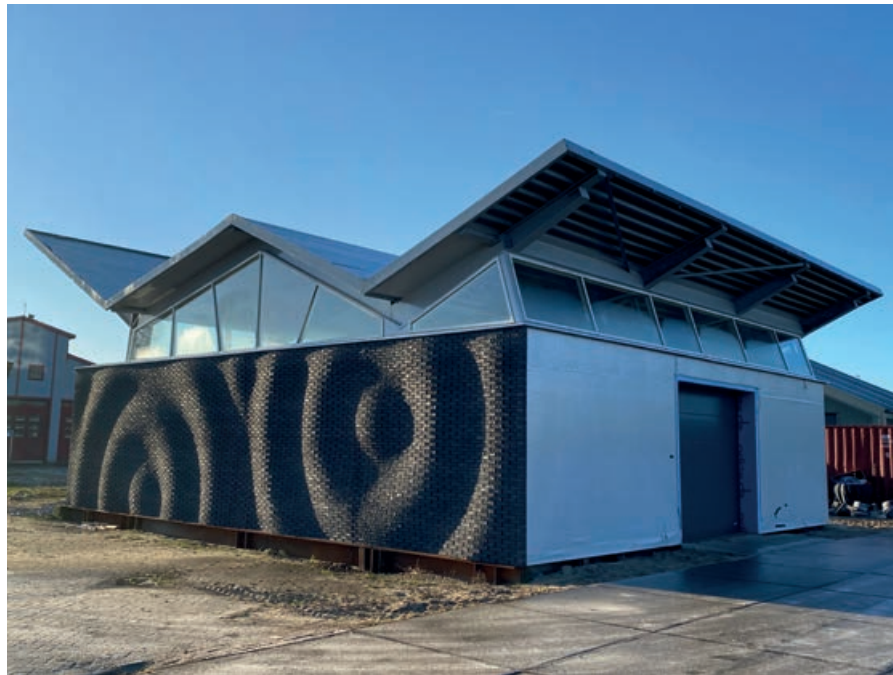
Met de metselrobot van Stack3D is een bakstenen gevel van het nieuwe Living Lab van 3D Makers Zone te Haarlem gerealiseerd. (Foto's: Marcel Ruben en Bouwlab)
