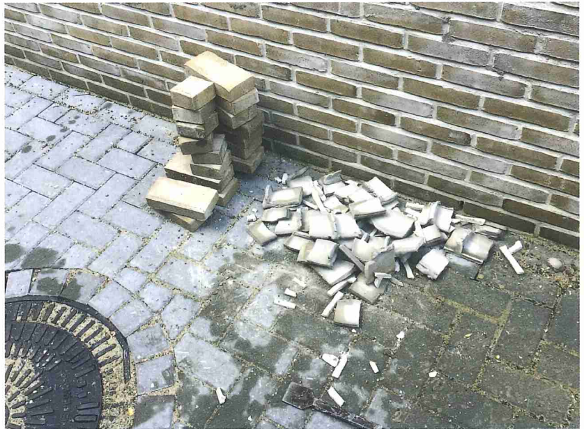
Foto boven Als bakstenen en mortel op deze wijze loskomen is er zeker geen sprake van voldoende hechting.
