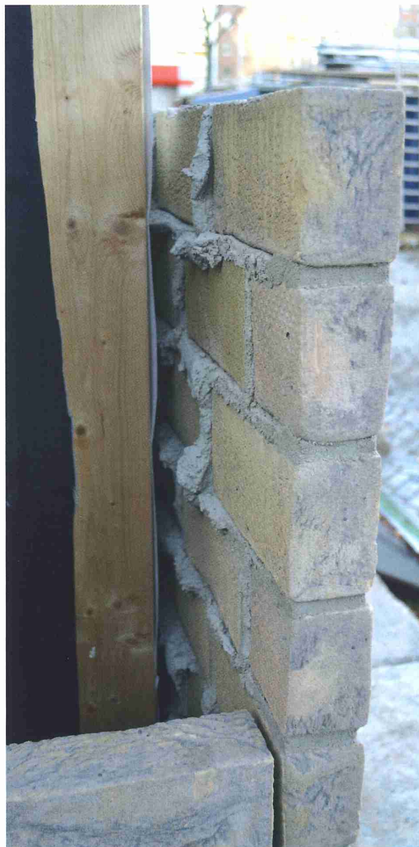
Foto boven Als bakstenen en mortel op deze wijze loskomen is er zeker geen sprake van voldoende hechting.
