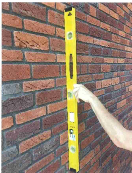
Wijze van meten van de vlakheid van gevelmetselwerk.
