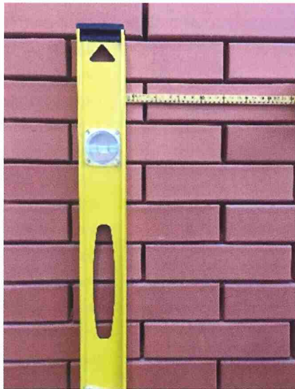
Wijze van meten van de regelmaat van het metselverband, oftewel de rechtlijnigheid van boven elkaar gelegen stootvoegen.
