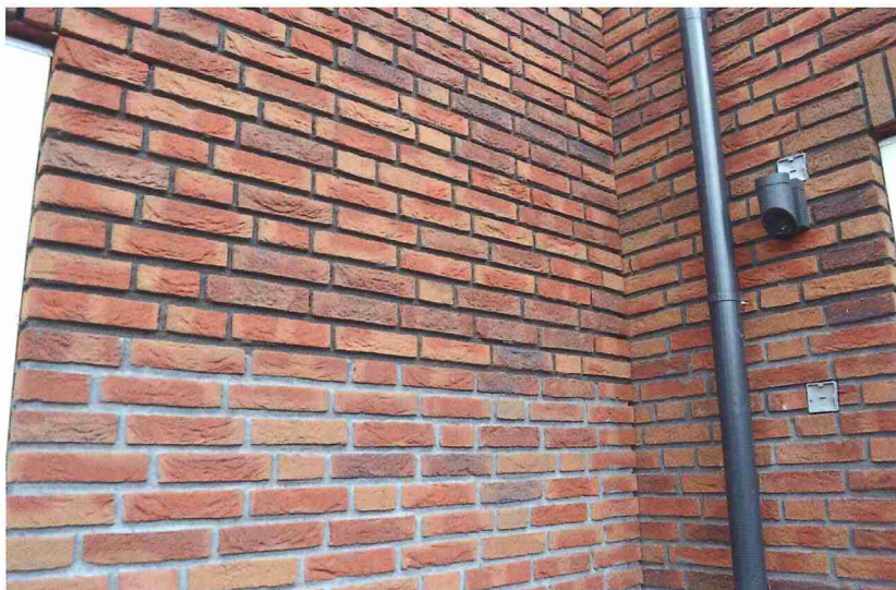
Naast kleurverschil komt ook verschil in voegdiepte veel voor.
