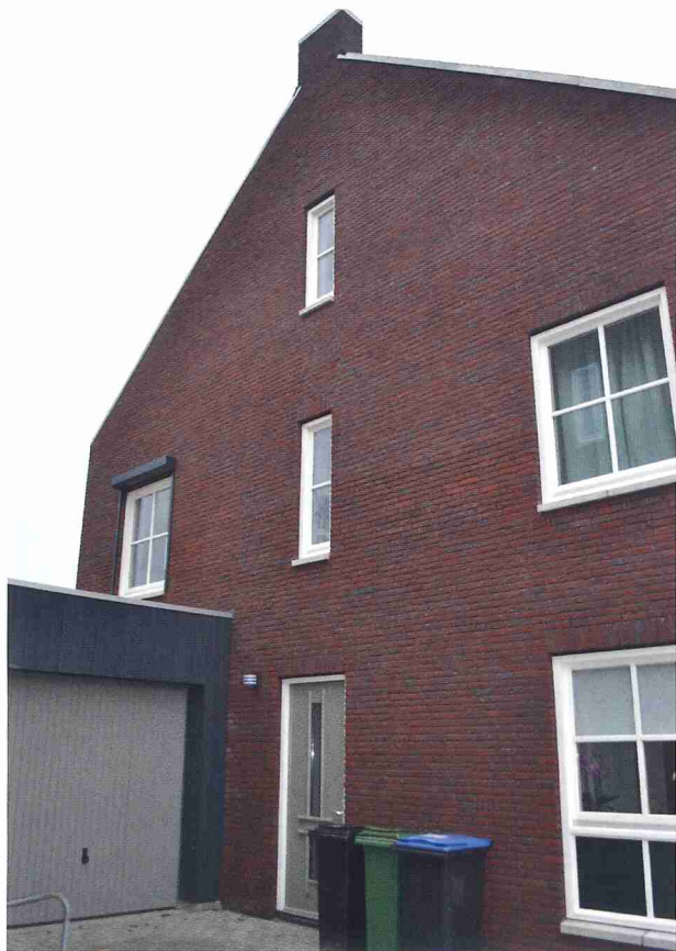
Gevelmetselwerk moet worden beoordeeld met diffuus licht en winddroog oppervlak. En dus niet met directe zonbelichting of strijklicht.
