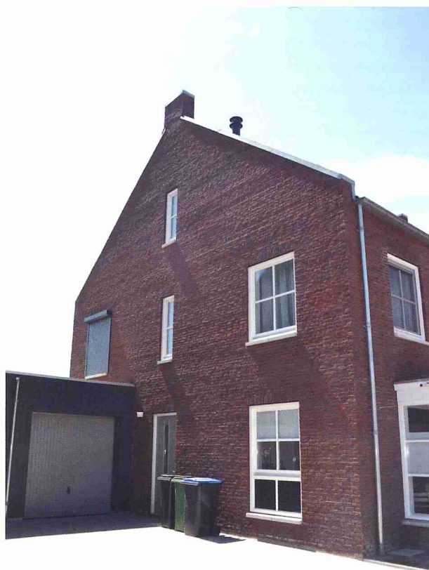
Gevelmetselwerk moet worden beoordeeld met diffuus licht en winddroog oppervlak. En dus niet met directe zonbelichting of strijklicht.
