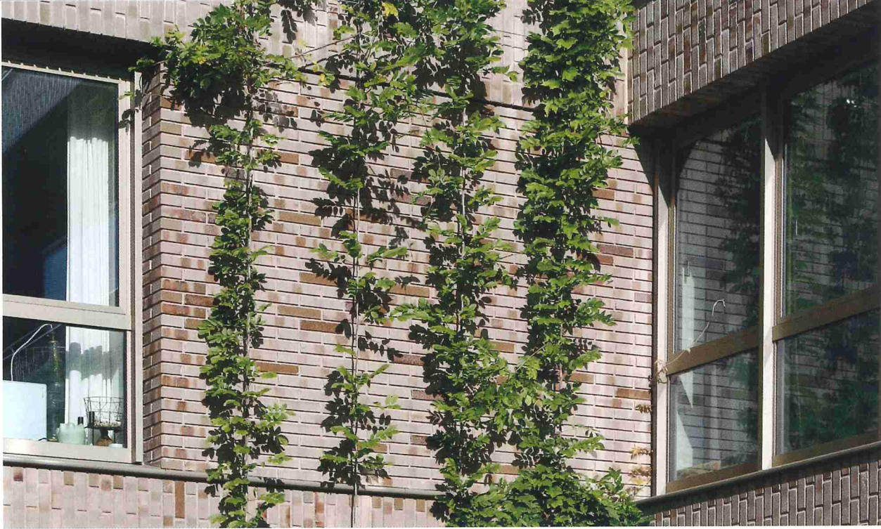
Klimhulpsysteem met spankabels op een metselmuur. (Foto: Carl Stahl Green Walls)
